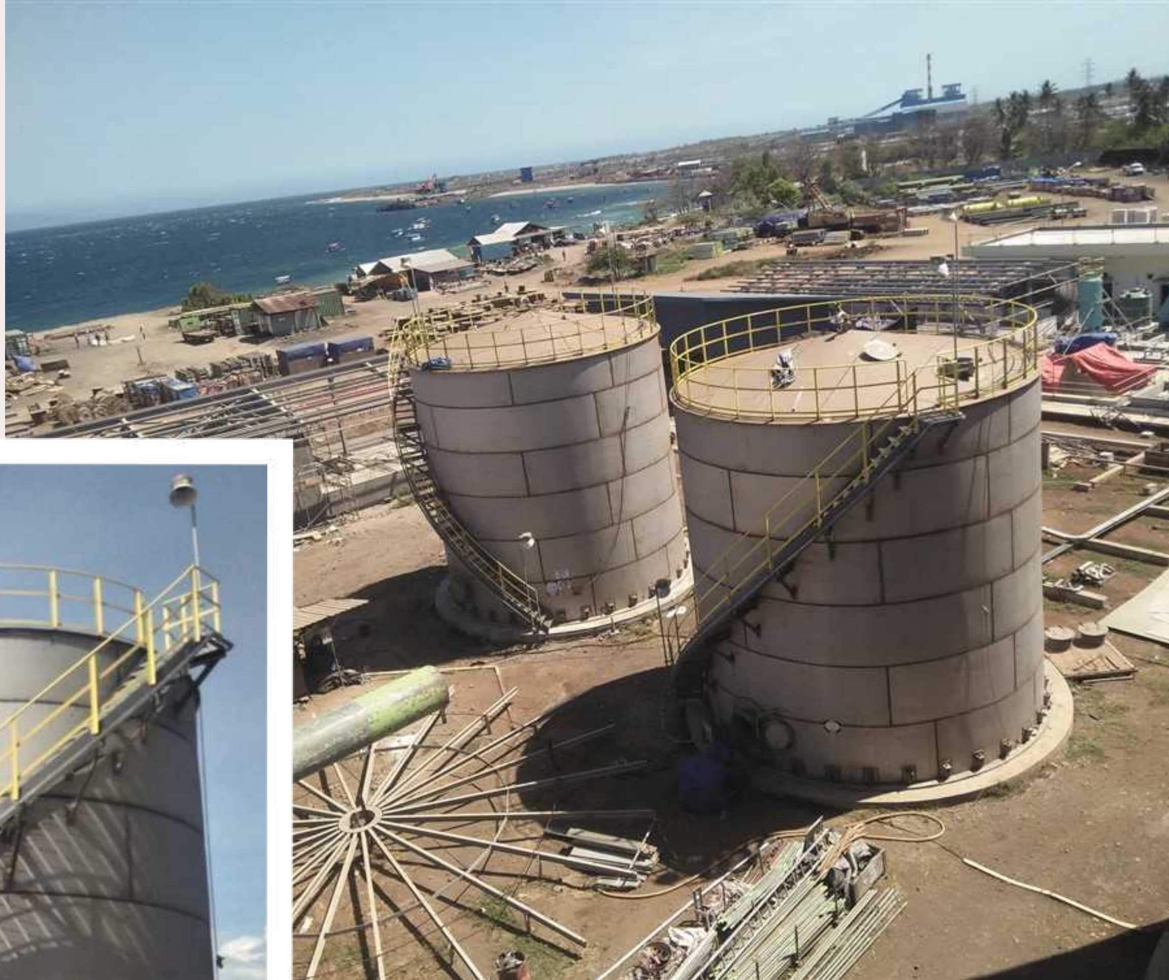
LOMBOK CFSPP FTP-2 (2x50 MW) Project PLTU LOMBOK
